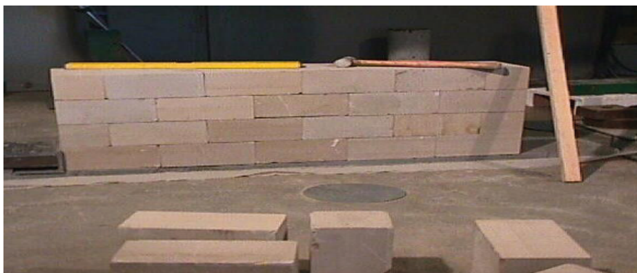
Figura 5: Muro de blocos de pedra
